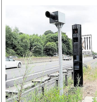
Der Laser-Blitzer (r.) dient während der Zeit der Baustelle als Ersatz für die Geräte, die über Schleifen im Boden aktiviert werden. Foto: Siewert
