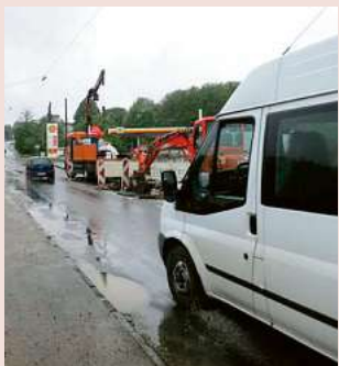
Montag regelt eine Baustellenampel den Verkehr. Foto: kam
