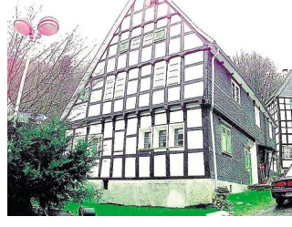
Am Mühlendamm in Unterburg wird derzeit gearbeitet. Foto: cb
