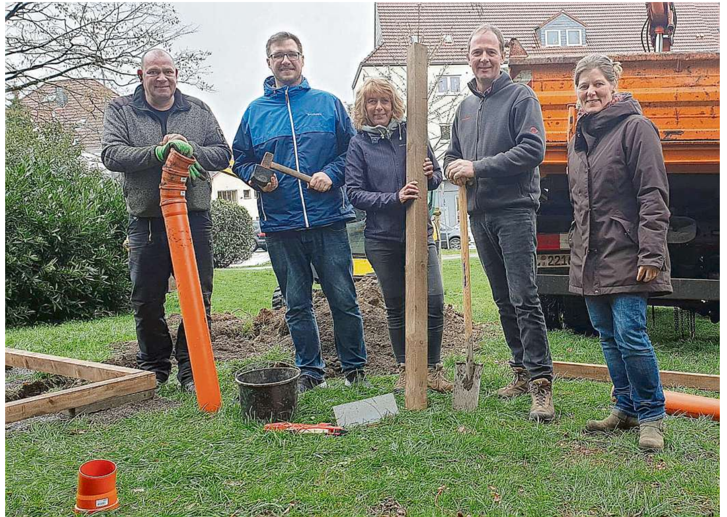
Ingo Wien (Betriebshof), Arne Clemm, Susi Madeja, Matthias Behr (Spielplatzpaten) und Elke Schütte (Betriebshof) packen gemeinsam an. Fotos: Siebel
