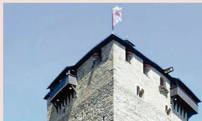
Der Bergfried wurde aufwendig saniert. Foto: Daniela Tobias
